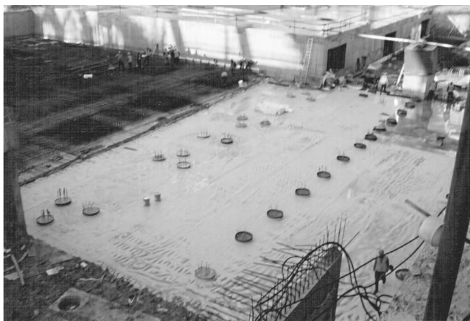
Рис. 1. Внешний вид гидроизоляции днища
